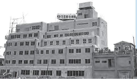
本館鉄筋化工事後。中央レントゲン棟、右は木造の第一病棟
