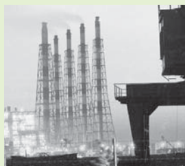
公害の元凶、関西電力火力発電所の150mと180mの煙突
