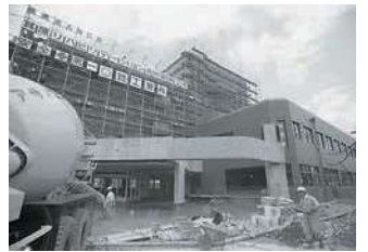
1981年建設中の耳原リハビリテーション病院
